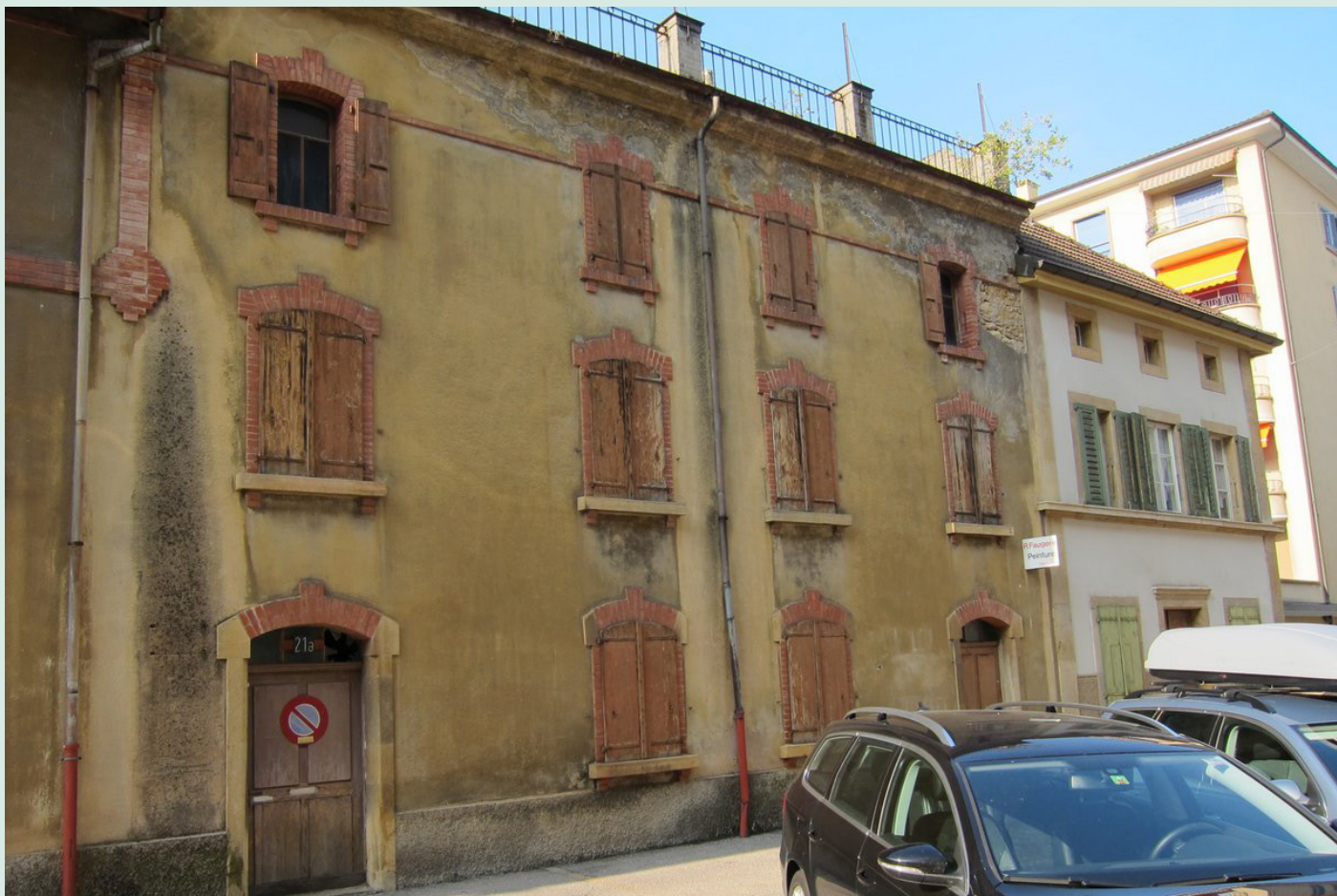
Front sud avant rénovation, 2013.
