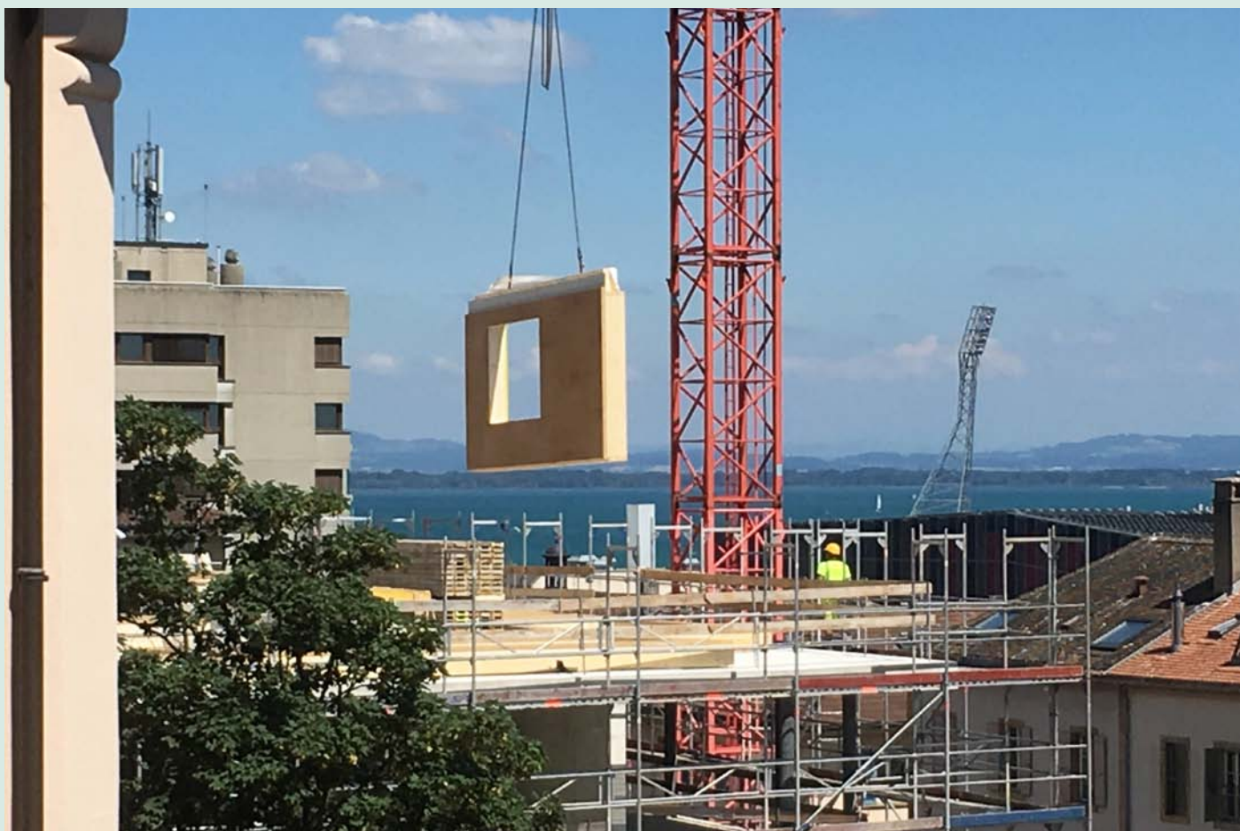
Pose des façades, 2018.
