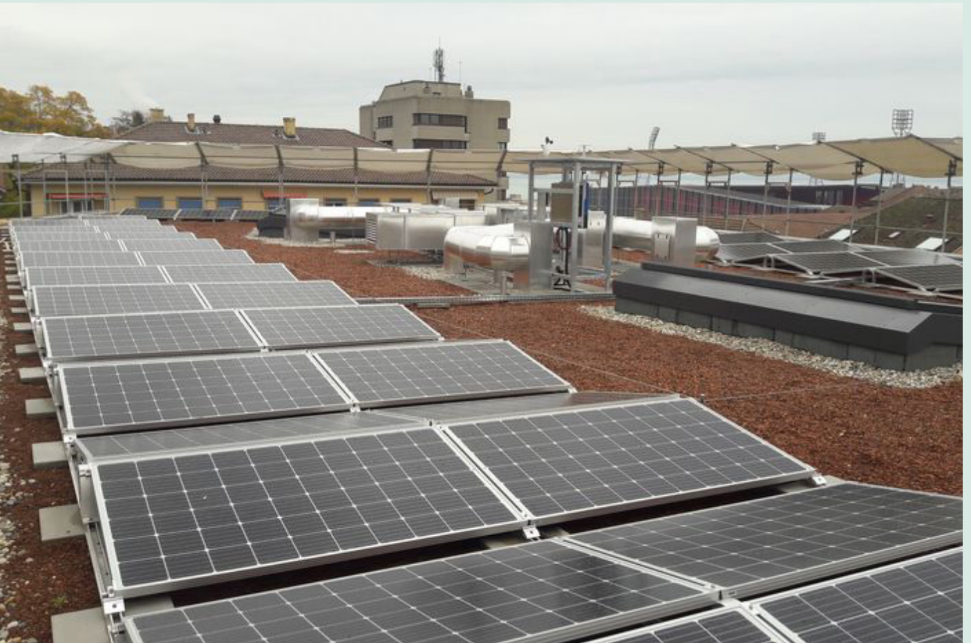
Pose des panneaux solaires (autoconstruction), 2018.
