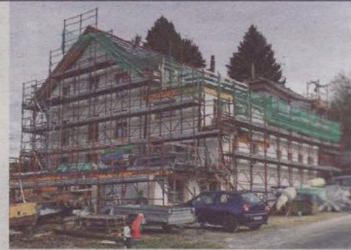
Huit appartements et cinq locaux artisanaux sont en construction dans le bâtiment.
