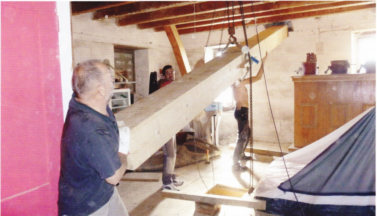
Les joies de l'autoconstruction: renforcement de la structure du moulin. © Moul2
