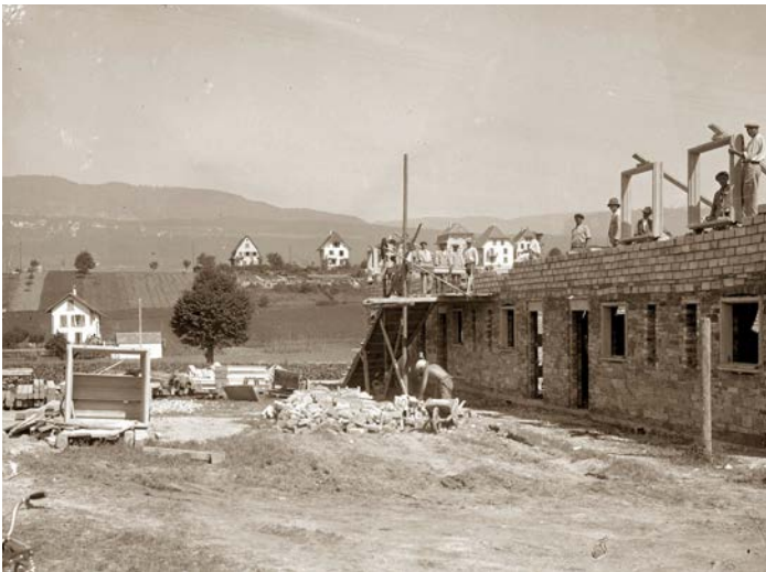
Daheim: Baustelle Mösti
