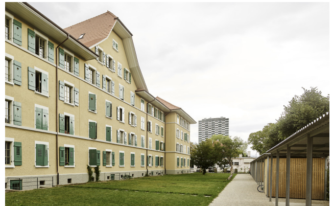
Südfassade Altbau Façade sud bâtiment ancien
