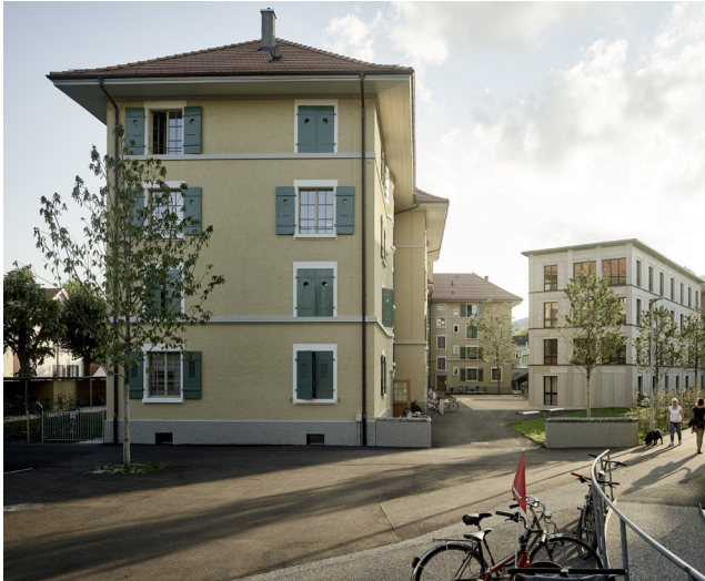
Ostfassade Façade est
