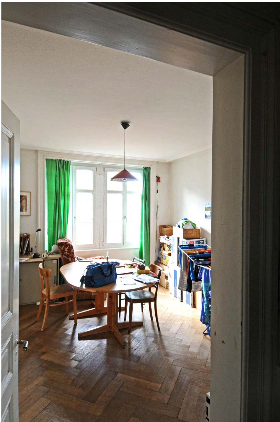
Abb. 33 Wohnzimmer: der Fischgratparkett und die Türen sind original erhalten. Die Fenster wurden wegen der Lärmbelästigung durch die angrenzende Strasse ersetzt.
