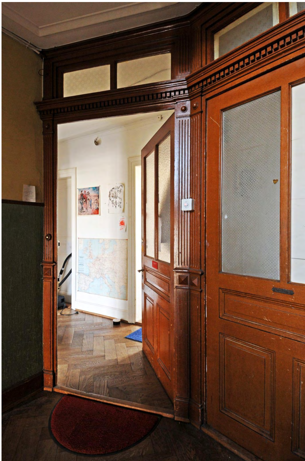
Abb. 32 Wohnungstür. Die Eingangstüren zu den Wohnungen sind alle original erhalten.
