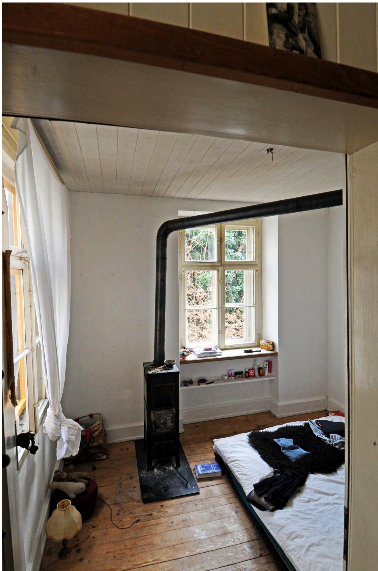
Abb. 16 Zimmer gegen Osten im ersten Obergeschoss: die Fenster, der Riemenparkett und der Ofen sind original erhalten.
